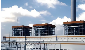
| 中国电建集团光伏电缆项目(山东)
